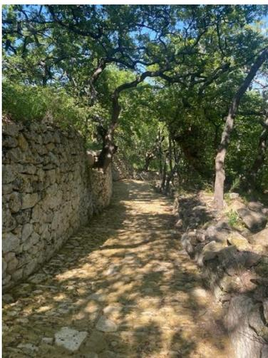
Le projet, réalisé par l'entreprise Silvasud, a concerné la réfection de 207 m linéaires de calade, la reprise des murs de soutènement, la pose d'un éclairage léger au sol à déclenchement par détecteur de présence, la pose de barrières en entrée et sortie.
